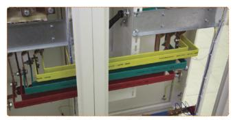
Соединения перекидных рубильников между собой, на вводных панелях, выполняется медными шинами.
